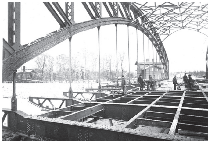
Rys. 2. Montaż stalowej konstrukcji przęsła nowego Passbrücke (źródło: Architekturmuseum der Technischen Universität Berlin)
