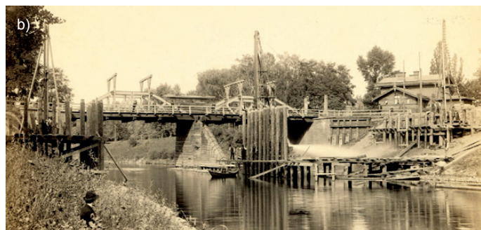
Rys. 1. a) widok na stary Passbrücke , b) proces przebudowy na most tymczasowy (źródło: Biblioteka Uniwersytetu Wrocławskiego)
